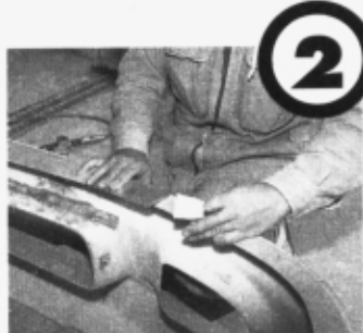
亀裂をうまく噛み合わせるか、少し切って、段スレがないようにする。そして、アルミテープで外側を固定する
